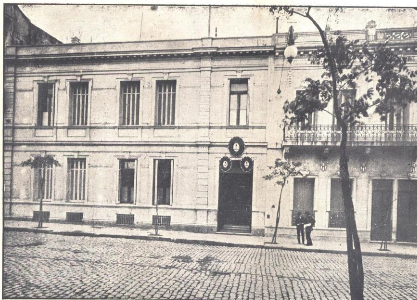
Hauptgebäude. Valentín Gómez 3163.
