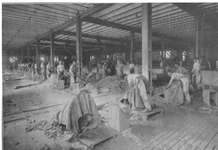
Figura 8. Trabajos de ribera
